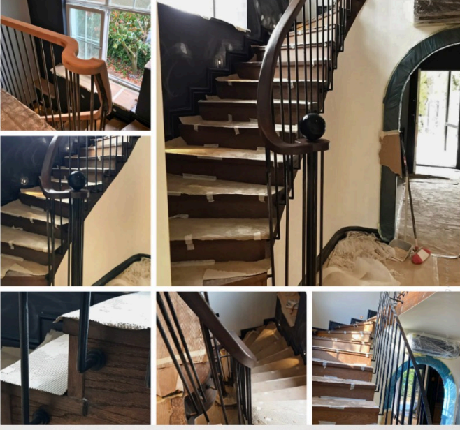
Ahsap küpeşteli elektrostatik boyalı korkuluk
